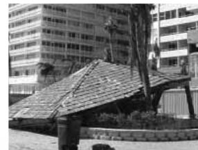
Wilma collapses Tiki Bar
